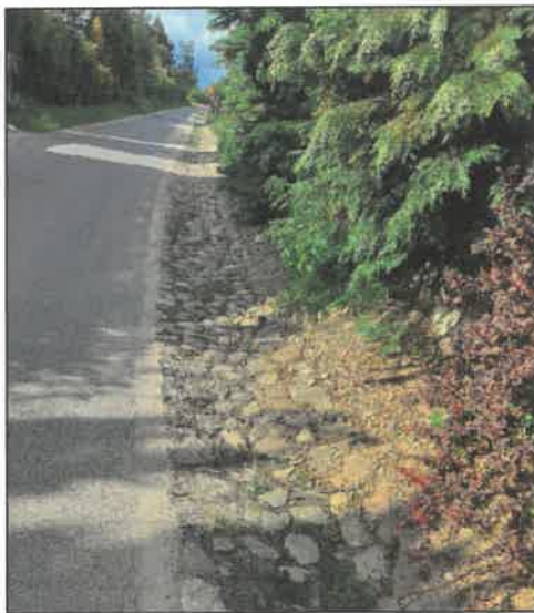
Odwodnienie drogi w Żukowie
