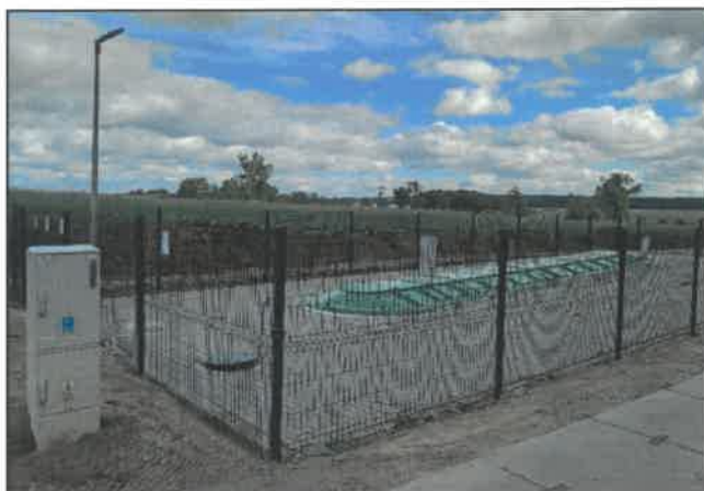
Oczyszczalnia ścieków w Sadłowie
