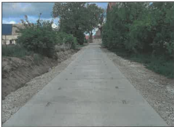
Droga w Sadłowie
