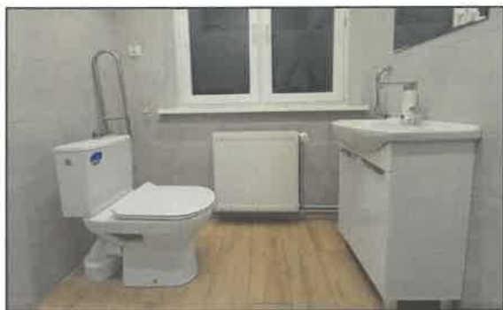
Wyremontowane pomieszczenie socjalne
