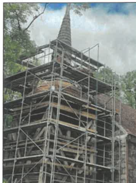
Remont dzwonnicy w Modrzewie
