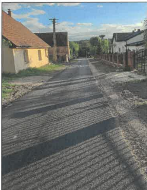
Droga w Suchanówku
