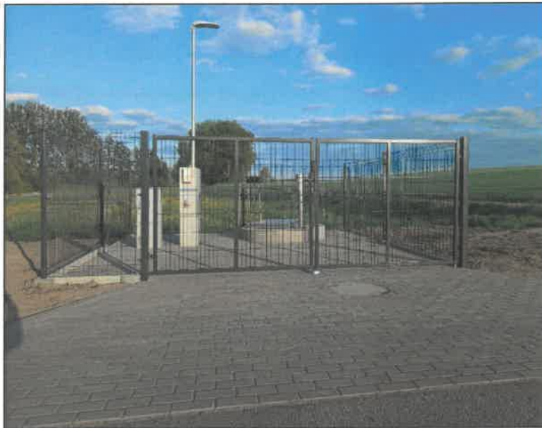
Przepompownia ścieków w Suchanówku
