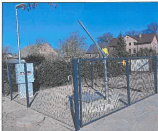
Przepompownia ścieków w Żukowie
