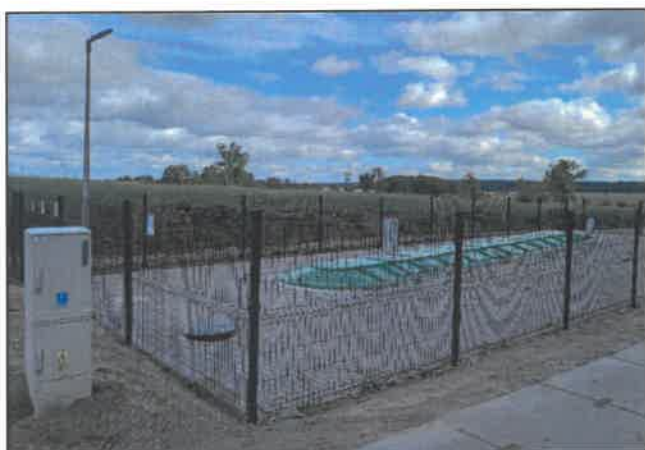
Oczyszczalnia ścieków w Sadłowie
