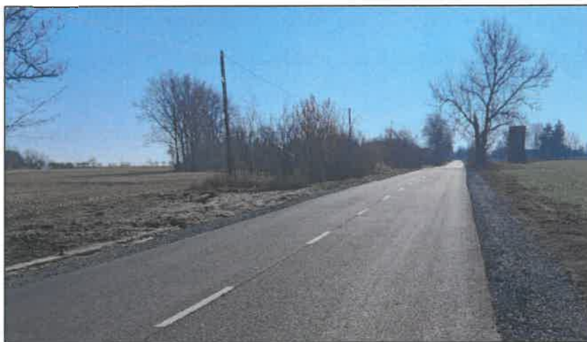
Droga Brudzewice – Pężino
