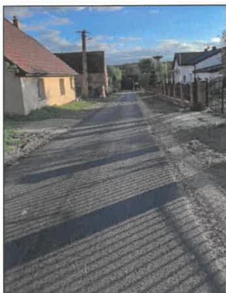
Droga w Suchanówku
