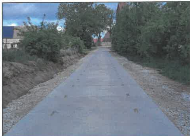
Droga w Sadłowie
