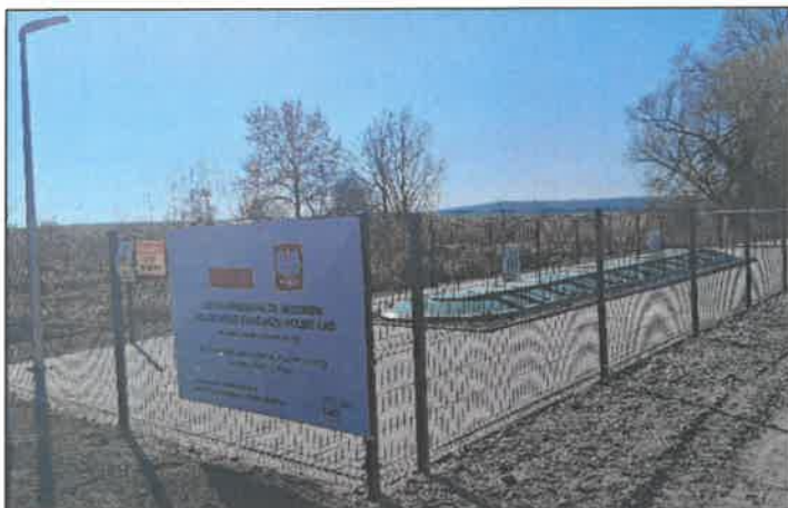
Oczyszczalnia ścieków w Żukowie
