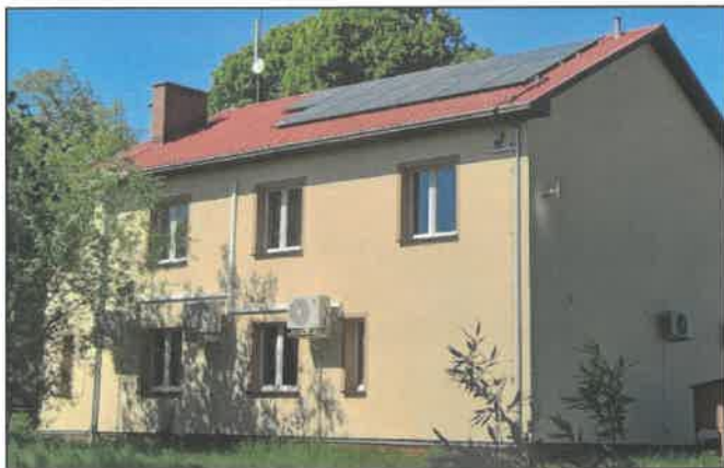
Instalacja fotowoltaiczna na świetlicy w Nosowie
