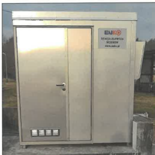
Stacja zlewna w Suchaniu
