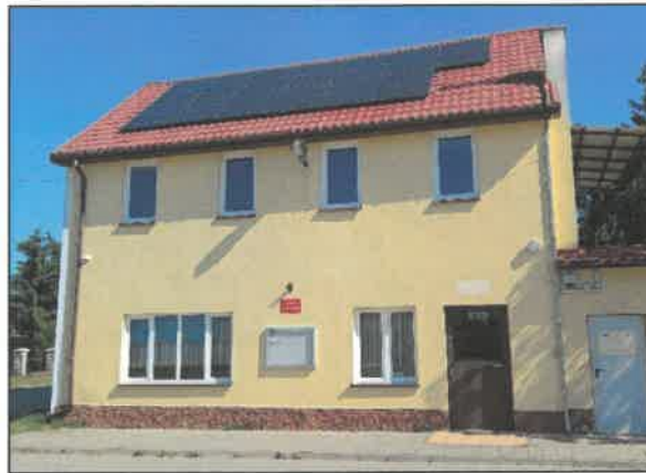
Instalacja fotowoltaiczna na świetlicy w Żukowie
